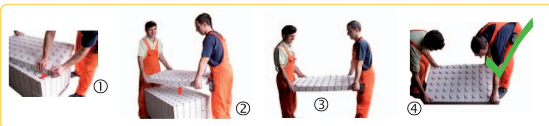
Posez d'abord un chant des panneaux compacts, puis mettez les panneaux à plat. L'entreposage vertical entraîne des déformations des panneaux et endommage les chants. Le transport horizontal des panneaux dans le bâtiment est possible avec des chariots-élévateurs ou d'autres chariots destinés au transport de panneaux.
