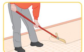
Une fois les 3 heures (à 20 °C) suivant l'épandage de la pâte de remplissage compacte écoulées, vous devez donner une couche d'apprêt (exemples de produits cf. chapitre 4.3) sur la surface du plancher chauffant compact avant d'ajouter la 2<sup>e</sup> couche de pâte de remplissage compacte. Pour ce faire, mélangez 25 kg de pâte de remplissage compacte avec 10 l d'eau. Prévoyez env. 0,5 kg/m<sup>2</sup>.
