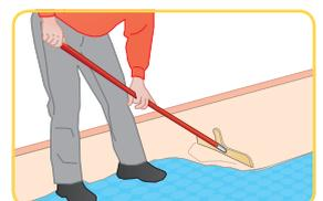
Afin d'égaliser davantage la surface, utilisez une pâte de nivellement pour plancher à base de sulfate de calcium (cf. chapitre 4.3).
